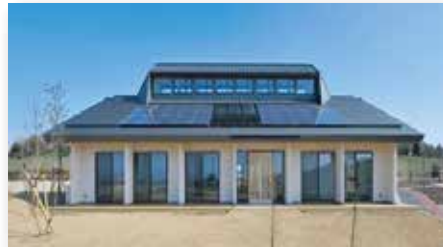
群馬県太田市のスーパーエコハウス(2010年竣工)
